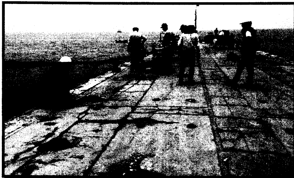
FOTO N°25: SE OBSERVA QUE SE ESTA VERIFICANDO EL TRAZO Y REPLANTEO. USANDO SUS EPP's.
