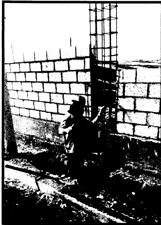
FOTO N°08: SE OBSERVA AL PERSONAL OBRERO CON SUS EPP's EN EXCAVACION DE ZANJA
