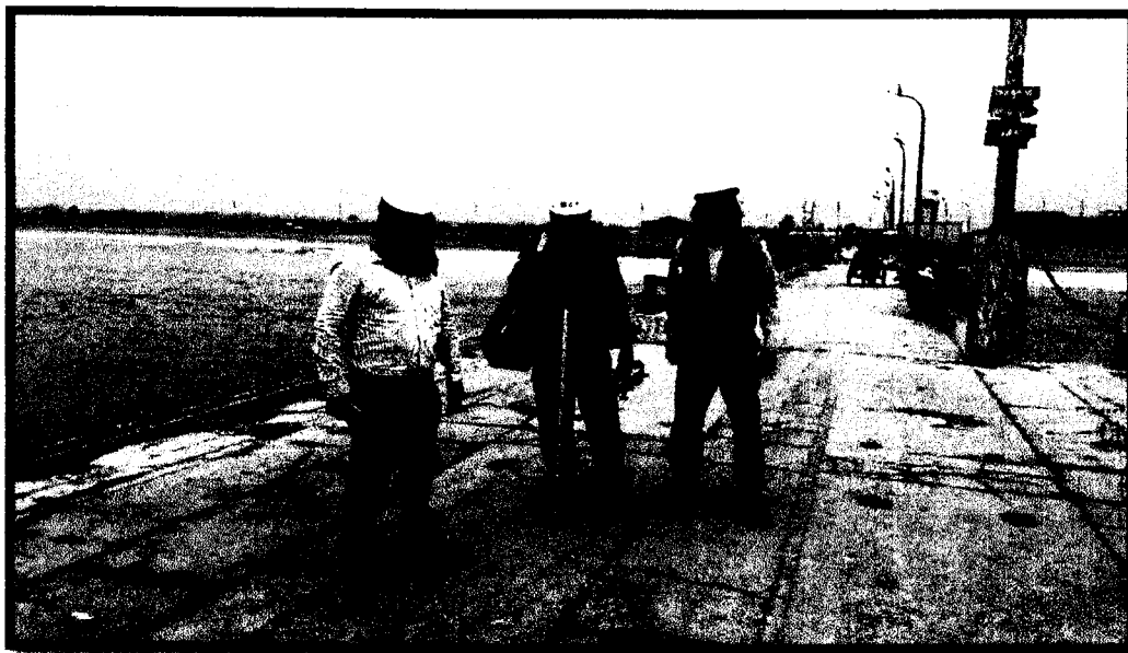
FOTO N°26: SE OBSERVA AL INGENIERO DE SEGURIDAD Y AL ASISTENTE DE SEGURIDAD JUNTO AL TOPOGRAFO VIENDO EL AREA DE TRABAJO EN EL MUELLE.
