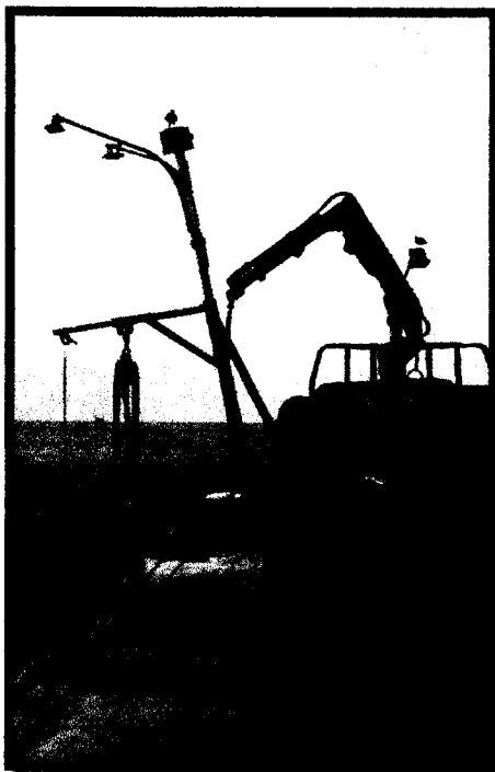
FOTO N°20: SE OBSERVA EL RETIRO DEL PESCANTE DE METAL CON LA GRUA DELIMITANDO EL AREA ENCINTADAS Y ENMALLADAS.
