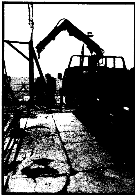
FOTO N°18: SE OBSERVA LA INICIACION CON LA GRUA PARA EL DESMONTAJE DEL PESCANTE. CERCADO EL AREA CON CINTAS Y MALLAS PROHIBIENDO EL PASO A VEHICULOS Y PERSONAS NO RELACIONADAS AL TRABAJO DE LA OBRA.
